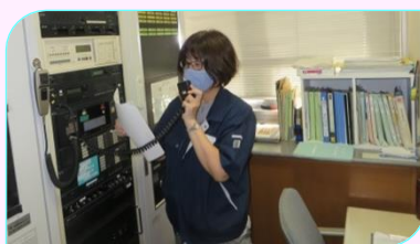
緊急館内放送の様子
